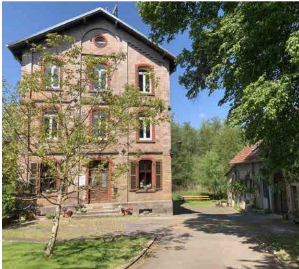
Rohrbacher Mühle, Mühlstraße 36: Nachhaltigkeitsprogramm
