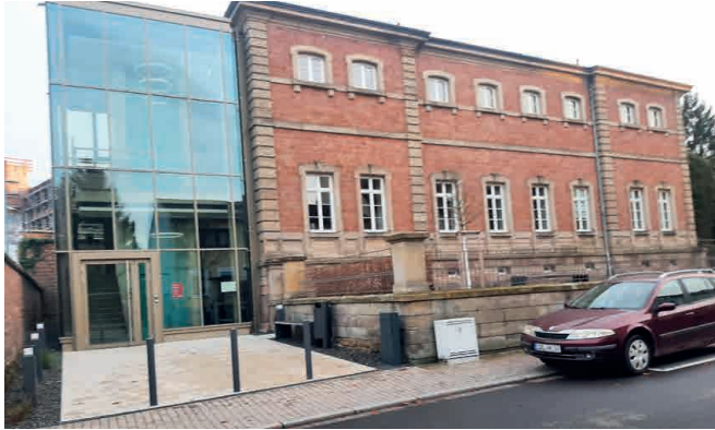
VHS-Geschäftsstelle, Alte Bahnhofstraße 11
