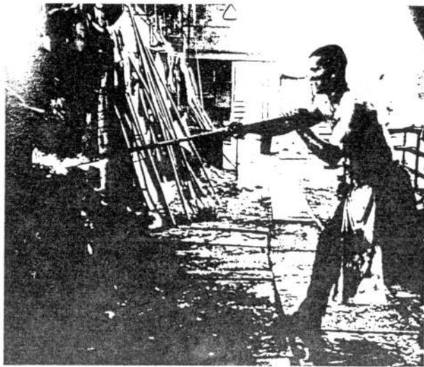
Abb.3: Die Arbeit des Puddlers unmittelbar vor der halbgeöffneten Ofentür war äußerst anstrengend und erforderte beträchtliches Geschick
