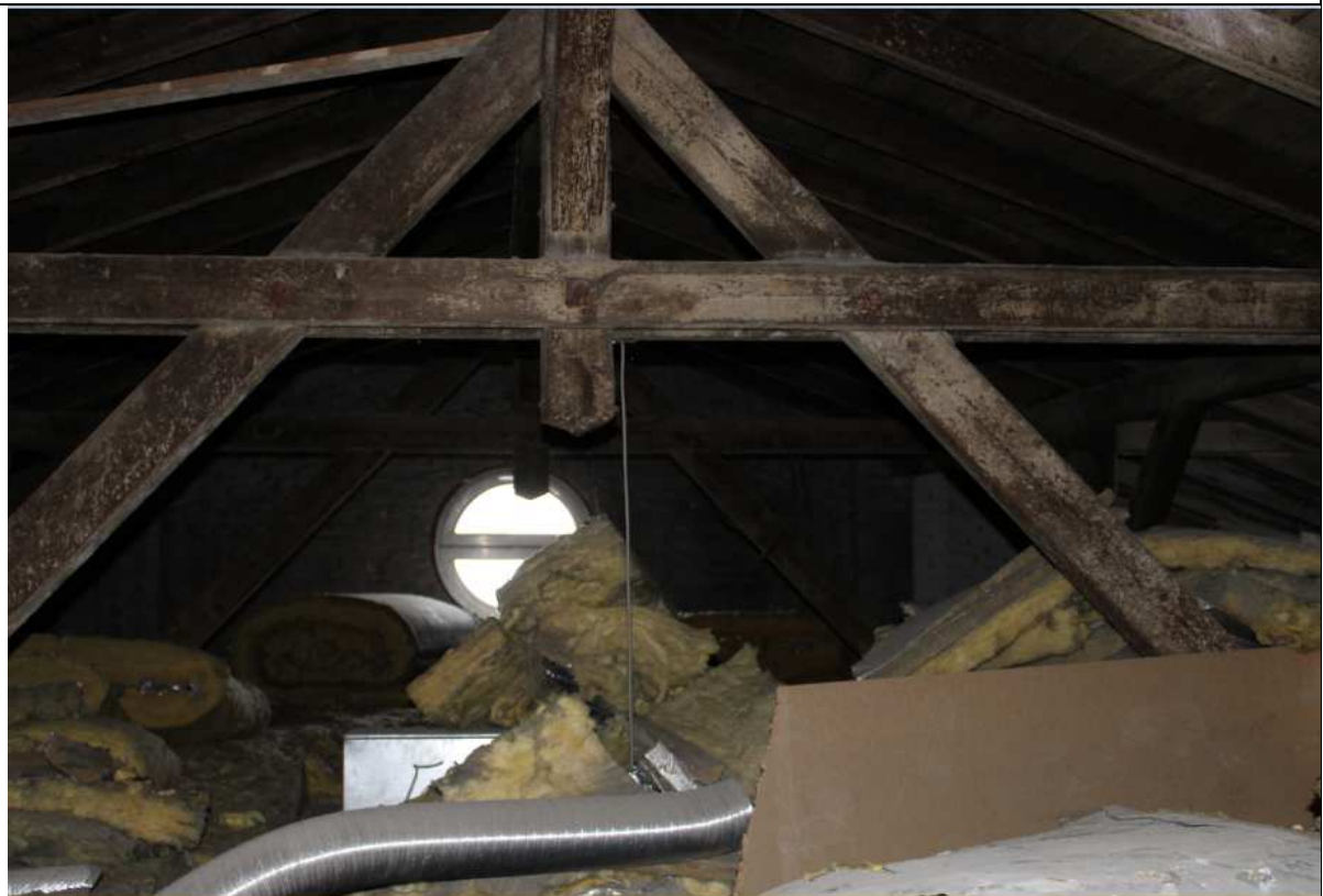
Foto 4: Dachstuhl des Gebäudes „Werkzeugbau“
