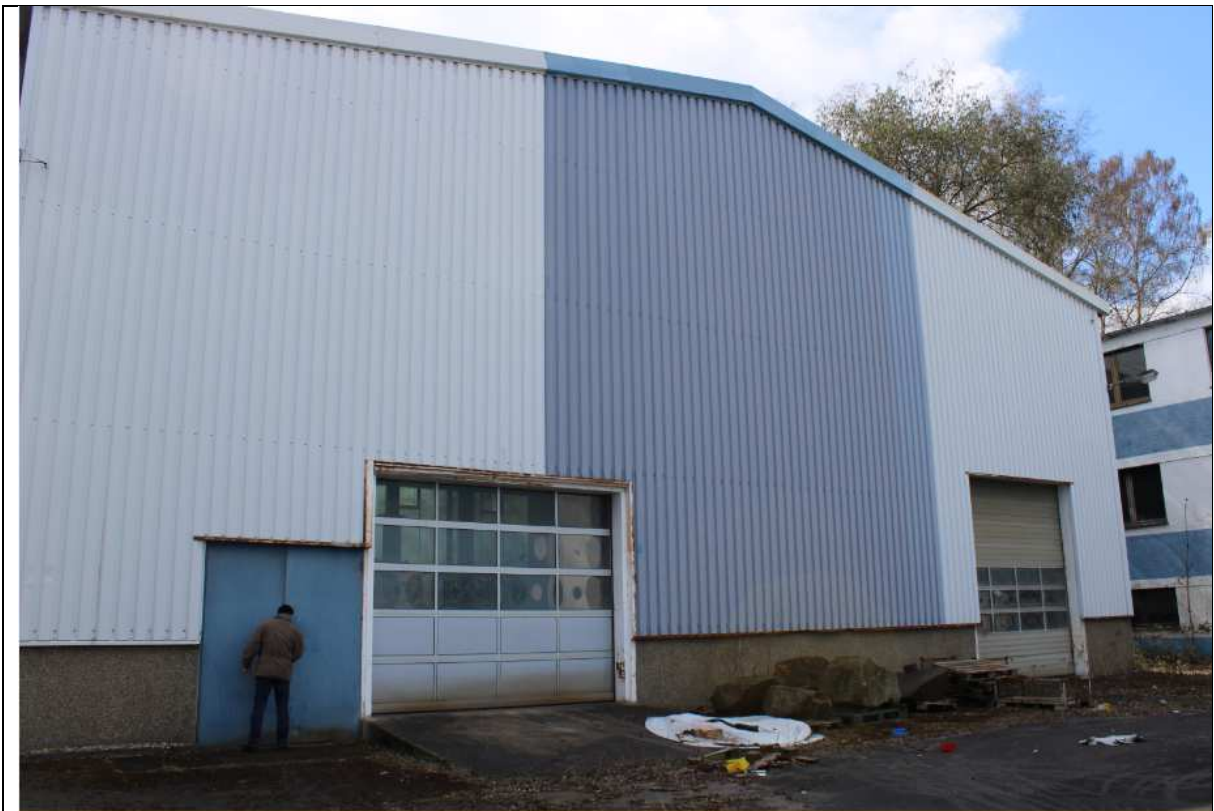
Foto 1: Metallbauweise der Hallen
