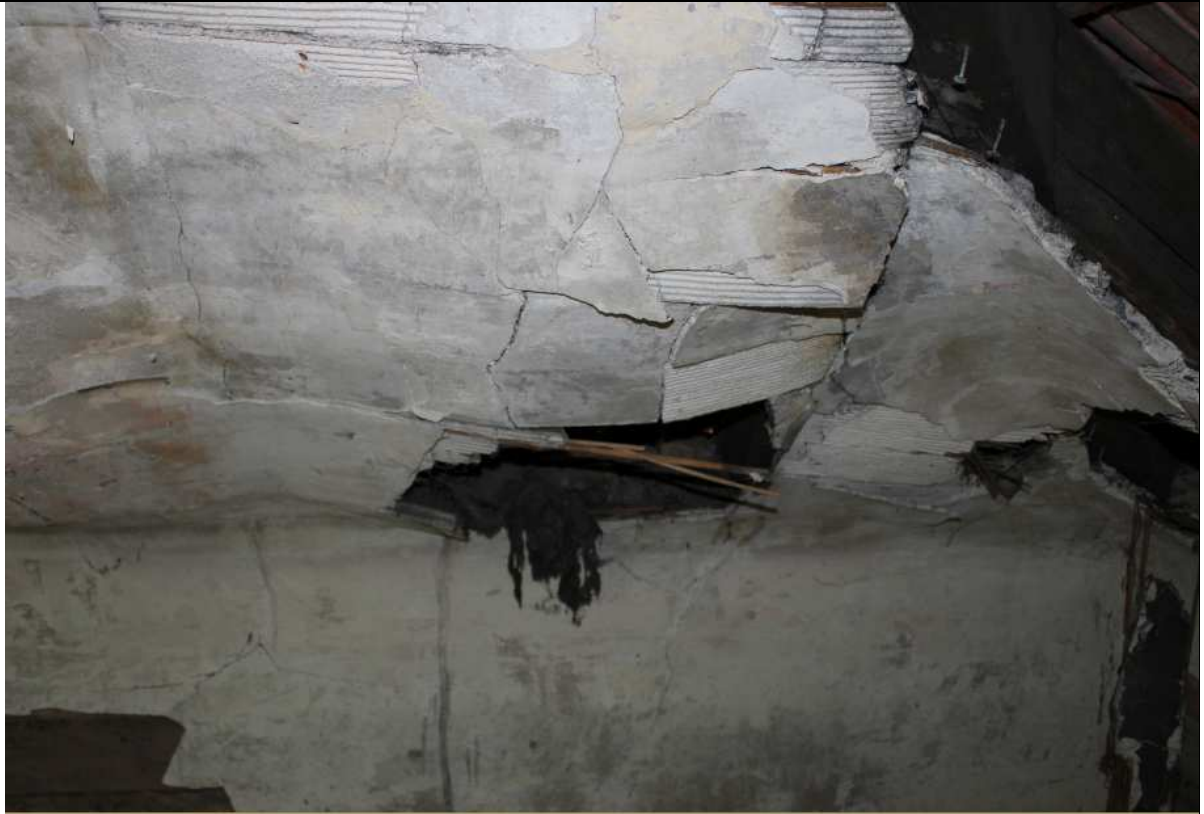
Foto 5: Rohrmattendecke im Dachstuhl des Gebäudes „Konstruktion“
