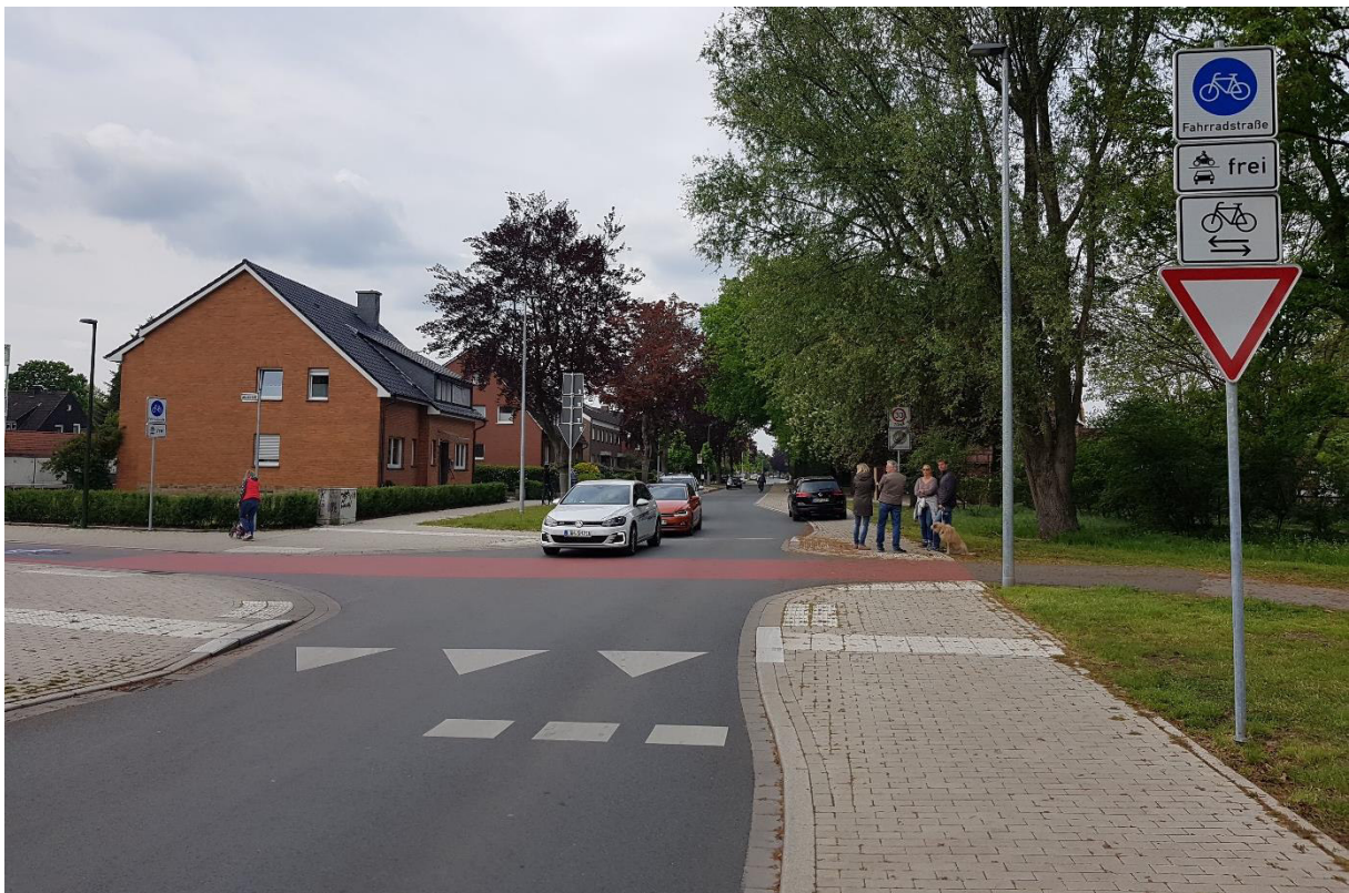
Abbildung 47: Angehobener Kreuzungsbereich, Erschließungsstraße mit Nachrang (Lünen, Akazienstraße)
