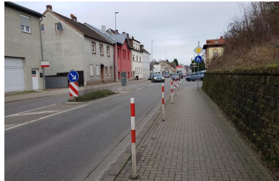
Abbildung 17: Fehlende Einfädelung auf Fahrbahn
