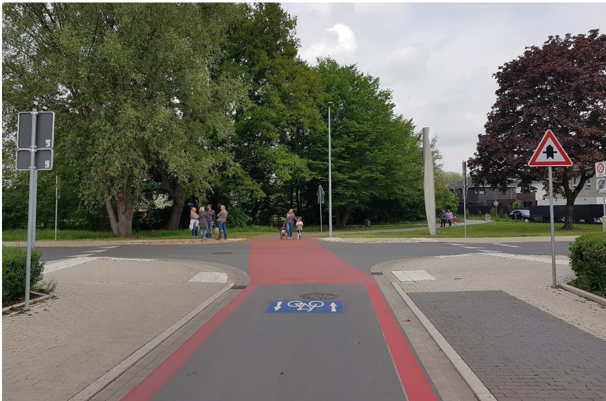
Abbildung 46: Angehobener Kreuzungsbereich, Fahrradstraße mit Vorrang (Lünen, Akazienstraße)
